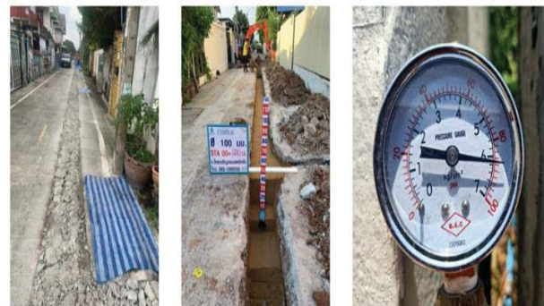
ดำเนินการเจาะผิวจราจร ระยะทางไม่เกินกิจกรรมสั้น ๆ ที่ทำได้ในวันทำการคือวันละประมาณ 100 เมตร เพื่อลดข้อร้องเรียนขุดแล้วไม่กลบ ที่ยังอ้างกันมาว่าดำเนินการได้ 100% ของความสามารถในการขุดเจาะ แต่ในขณะเมื่อเห็นผิวจราจร ไม่ค่อยขุดเท่าที่ควรในวันถัดไป
