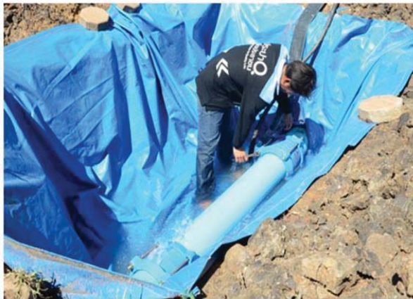
ยังใช้การติดตั้งระบบประปาโดยใช้ช่างนำผ้าใบเพื่อป้องกันสิ่งสกปรกเข้าปะปนภายในพื้นที่ ข้อร้องเรียนเรื่องน้ำประปาขุ่น
