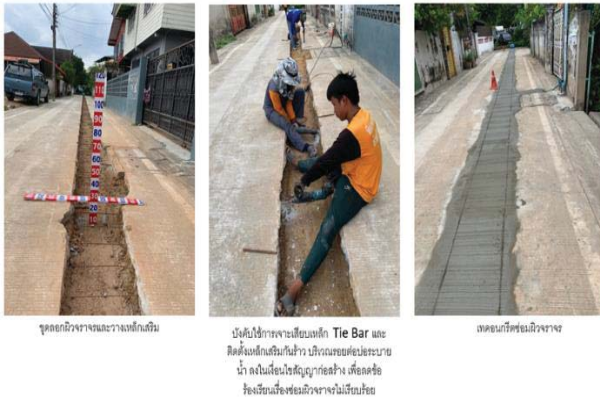
ภาพที่ 5- 2 ขั้นตอนการก่อสร้างรางท่อประปาที่ปรับปรุงแล้ว (ต่อ)
