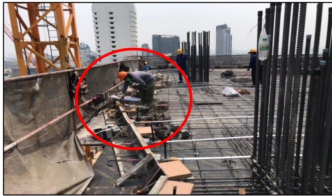
รูปที่ 4.29 ตัวอย่างการทำงานสนับสนุนของงานวางลวดสลิง งานร้อยท่อสังกะสีแบบลอน งานติดตั้ง Bar-Chair งานติดตั้งอุปกรณ์สมอยึดลวดและงานติดตั้งท่ออัดน้ำปูน
