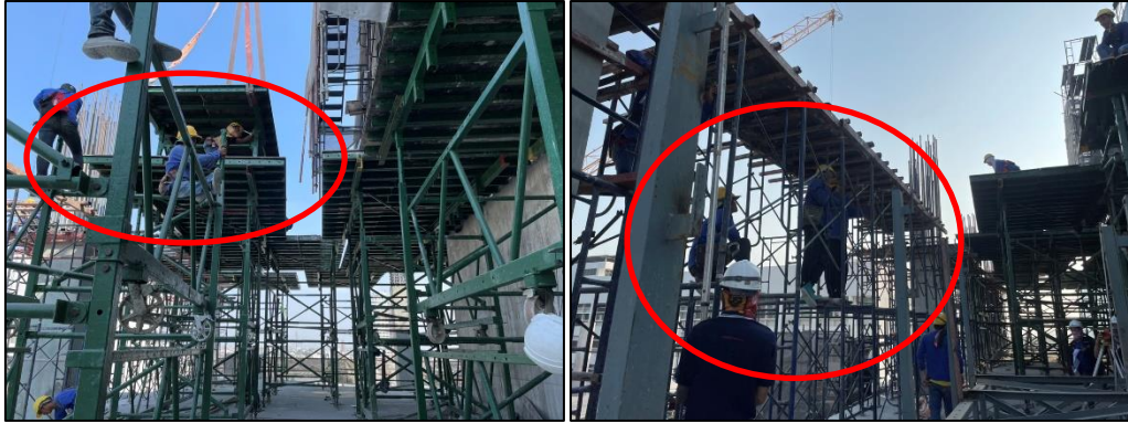
รูปที่ 4.21 ตัวอย่างการทำงานที่ได้ประสิทธิผลของงานติดตั้งโตะประกอบแบบ
