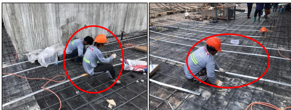
รูปที่ 4.27 ตัวอย่างการทำงานที่ได้ประสิทธิผลของงานงานวางลวดสลิง งานร้อยท่อสังกะสีแบบลอน งานติดตั้ง Bar-Chair งานติดตั้งอุปกรณ์สมอยึดลวดและงานติดตั้งท่ออัดน้ำปูน
