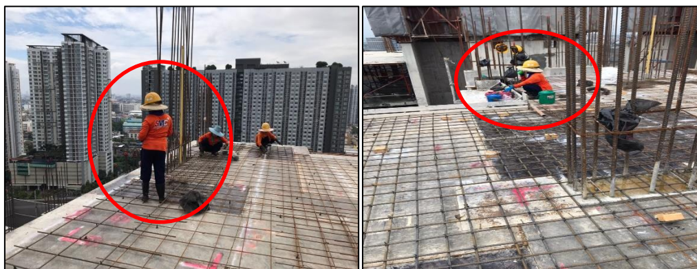
รูปที่ 4.12 ตัวอย่างการทำงานที่ไร้ประสิทธิผลของงานติดตั้งเหล็ก Posh Mesh และเหล็กเสริม
