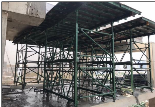
รูปที่ 2.1 การติดตั้งโต๊ะประกอบแบบในระบบพื้น Post Tension
