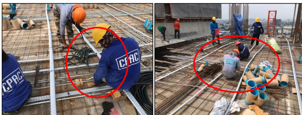
รูปที่ 4.13 ตัวอย่างการทำงานที่ได้ประสิทธิผลของงานงานวางลวดสลิง งานร้อยท่อสังกะสีแบบ ลอน งานติดตั้ง Bar-Chair งานติดตั้งอุปกรณ์สมอยึดลวดและงานติดตั้งท่ออัดน้ำปูน
