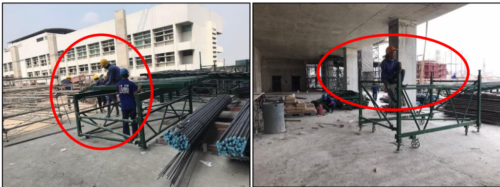
รูปที่ 4.22 ตัวอย่างการทำงานที่ไร้ประสิทธิผลของงานติดตั้งโตะประกอบแบบ
