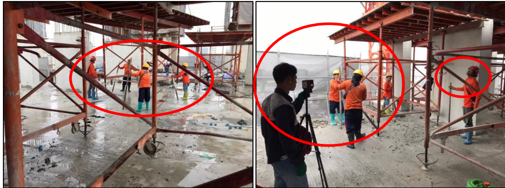
รูปที่ 4.6 ตัวอย่างการทำงานที่ได้ประสิทธิผลของงานติดตั้งโต๊ะประกอบแบบ
