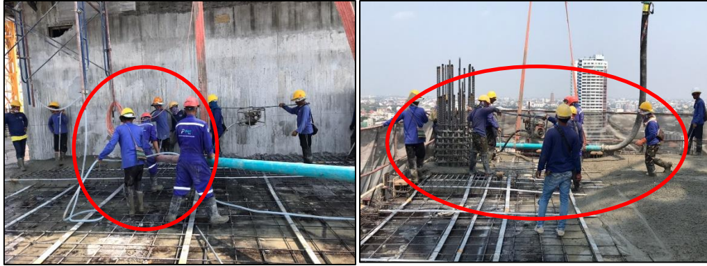
รูปที่ 4.31 ตัวอย่างการทำงานที่ได้ประสิทธิผลของงานเทคอนกรีต
