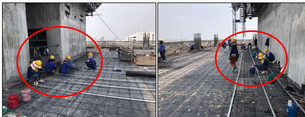
รูปที่ 4.26 ตัวอย่างการทำงานที่ไร้ประสิทธิผลของงานติดตั้งเหล็ก และเหล็กเสริม
