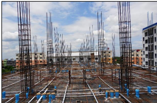
รูปที่ 2.4 การติดตั้งทวดสลิงร้อยท่อสังกะสี อุปกรณ์สมอยึดทวดและท่ออัดน้ำปูนในระบบพื้น Post Tension
