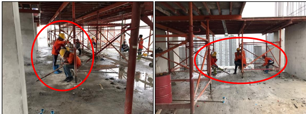
รูปที่ 4.7 ตัวอย่างการทำงานที่ไร้ประสิทธิผลของงานติดตั้งโต๊ะประกอบแบบ
