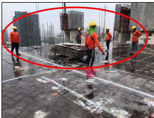
รูปที่ 4.9 ตัวอย่างการทำงานที่ไร้ประสิทธิผลของงานติดตั้งไม้แบบ
