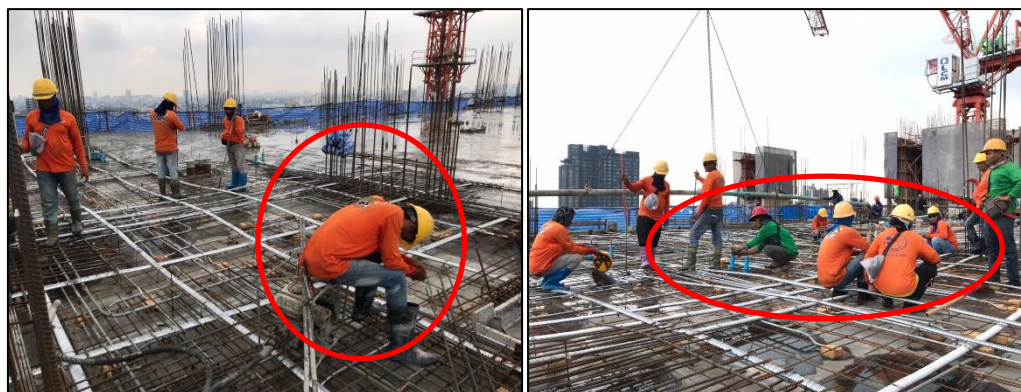
รูปที่ 4.16 ตัวอย่างการทำงานที่ไร้ประสิทธิผลของงานเทคอนกรีต
