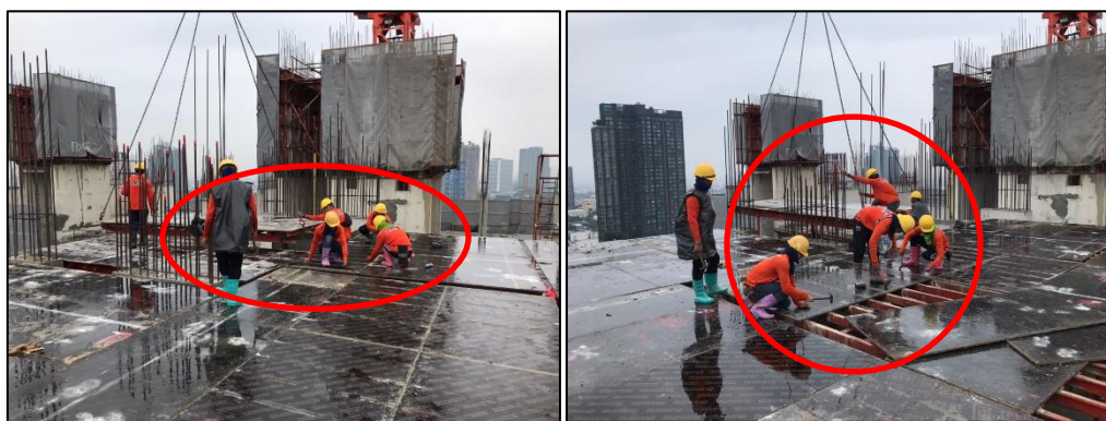
รูปที่ 4.8 ตัวอย่างการทำงานที่ได้ประสิทธิผลของงานติดตั้งไม้แบบ
