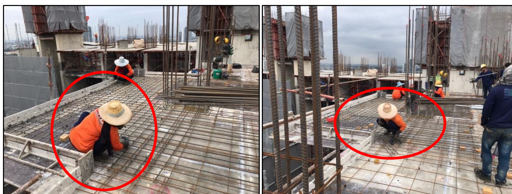
รูปที่ 4.11 ตัวอย่างการทำงานที่ได้ประสิทธิผลของงานติดตั้งเหล็ก Wire Mesh และเหล็กเสริม
