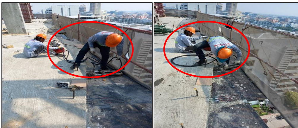
รูปที่ 4.33 ตัวอย่างการทำงานที่ได้ประสิทธิผลของงานดิ่งสลิ้งและอัดน้ำปูน
