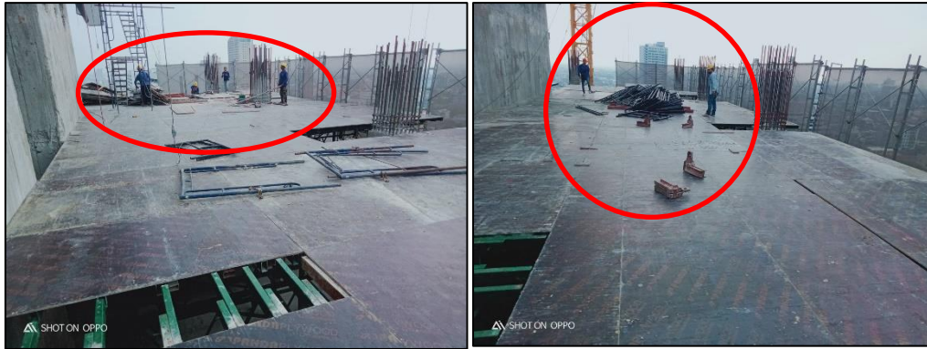
รูปที่ 4.23 ตัวอย่างการทำงานที่ได้ประสิทธิผลของงานติดตั้งไม้แบบ
