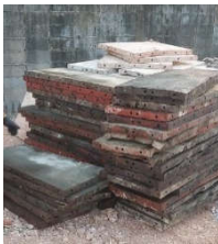
รูปที่ 6 จุดกองเก็บเหล็กและไม้แบบ
