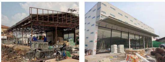
รูปที่ 1 โครงการก่อสร้างร้านสะดวกซื้อ
