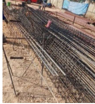
รูปที่ 5 เหล็กคานที่รอการใส่เหล็กปลอก
