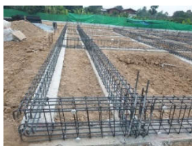
รูปที่ 10 ปรับปรุงการผูกเหล็ก
