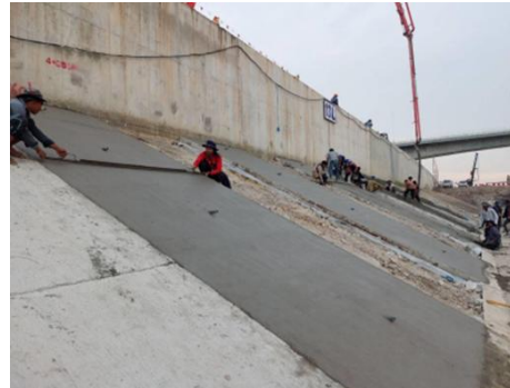
รูปที่ 15 งานเทคอนกรีตคลองระบายน้ำ (Concrete Lining)
