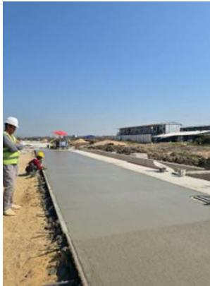
รูปที่ 19 งานเทคอนกรีตพื้นถนน (Concrete Road)
