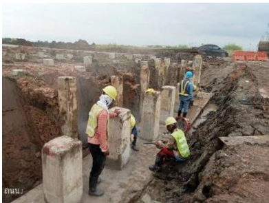
รูปที่ 3 งานตัดหัวเสาเข็ม (Pile Cut Off)
