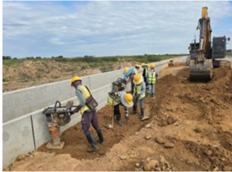
รูปที่ 11 งานถมดินข้าง U-Ditch
