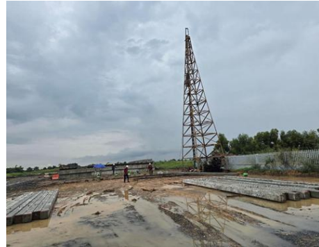
รูปที่ 7 งานตอกเสาเข็ม (Piling)
